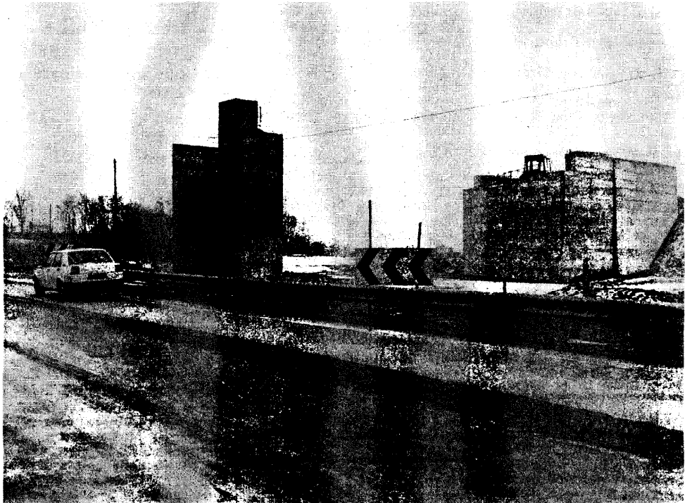
SERiate - Sta prendendo corpo il grande manufatto dello svincolo del primo tronco di «Tangenziale Sud» sulla statale «Soncinese» nei pressi del Cassinone. Da qui dovrebbe partire il secondo tronco che, sovrappassato il fiume Serio, si attesterebbe sulla statale «Cremasca» a sud di Zanica. Il terzo tratto della nuova grande arteria di traffico dovrebbe infine arrivare al casello autostradale di Dalmine. (Foto FLASH)
