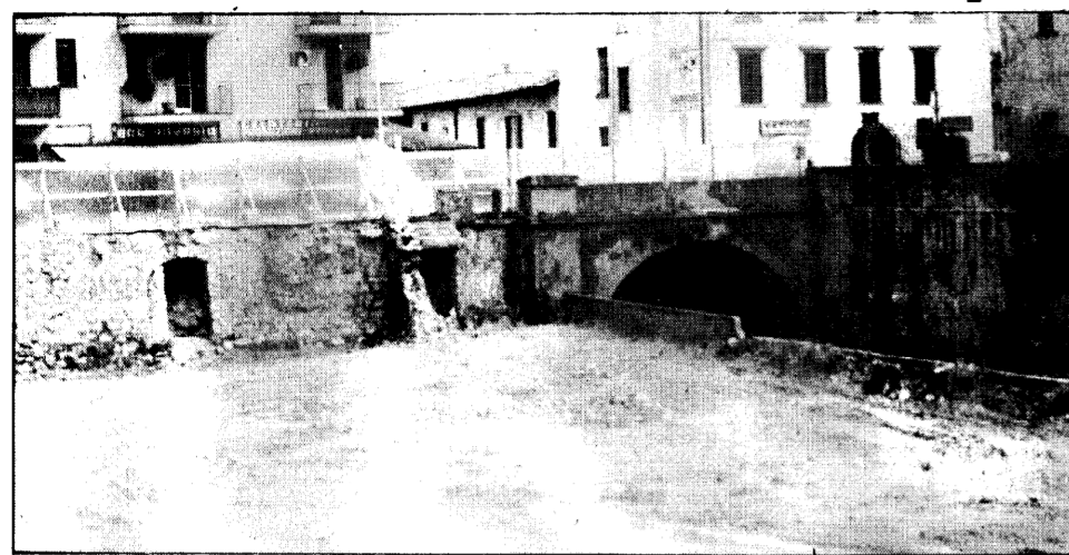
ALBINO — L'area su cui sta per sorgere il nuovo municipio. (Foto BREDA)
