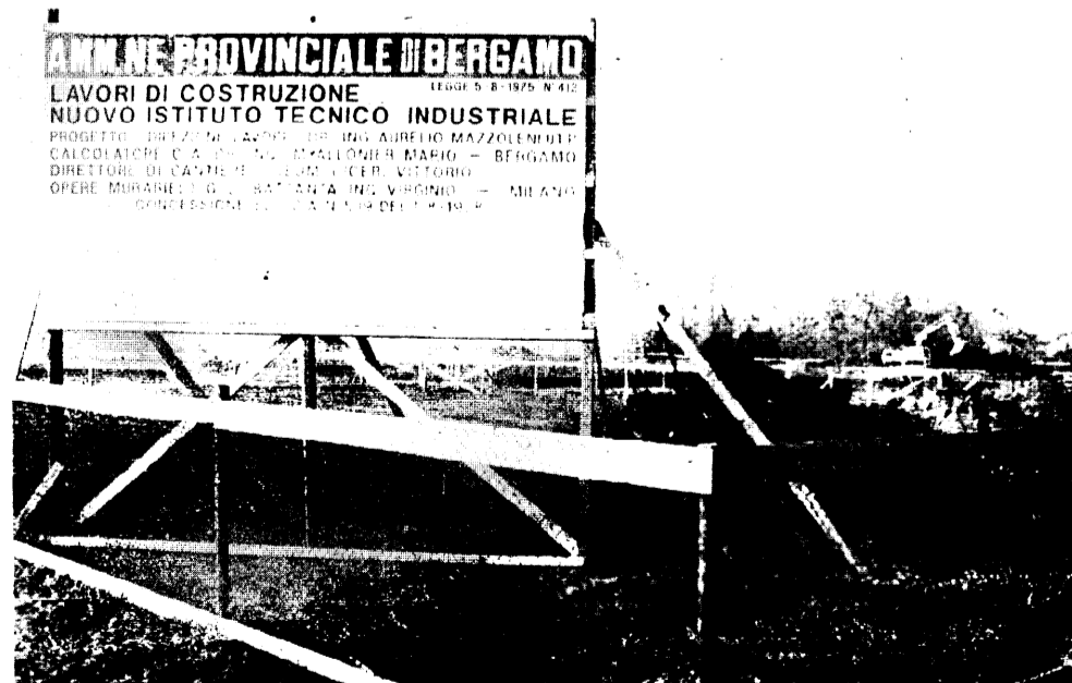
Una veduta panoramica della zona dei lavori per la sede del nuovo Istituto Tecnico Industriale a Dalmine. (Foto GHISLANDI - Dalmine)
